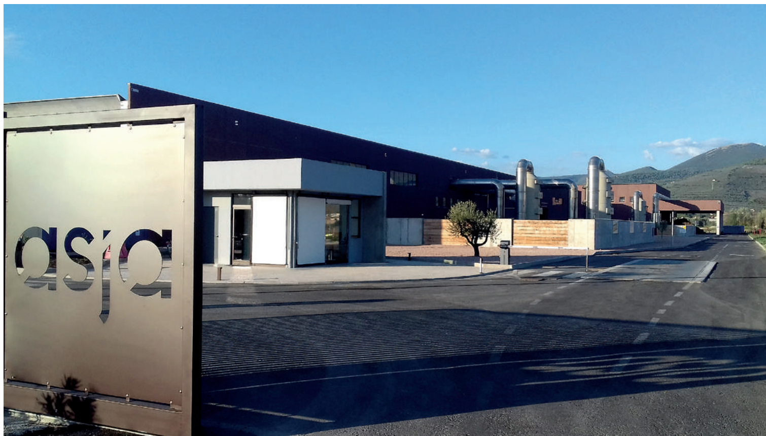
Impianto biometano di Foligno (PG). Pagina a fianco L'impianto di Belo Horizonte
