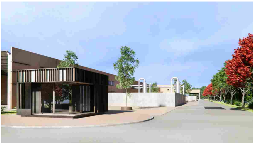
L'impianto in via di realizzazione della Asja ambiente a Foligno
