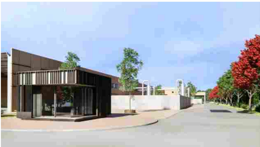
L'impianto a Biometano già realizzato a Foligno
