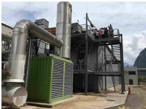
**caratteristiche che lo rendono all'avanguardia:** la trasformazione del rifiuto umido e del verde in biogas, attraverso il **processo di digestione anaerobica**, che avviene in assenza di ossigeno, consentendo di risparmiare acqua e smaltire una quantità maggiore di verde, e l'aspirazione dell'aria che limita al massimo la fuori uscita di inquinanti.
