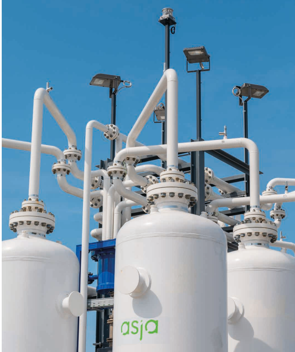
L'impianto di upgrading è di tecnologia PSA (Pressure Swing Absorbition) doppio stadio
