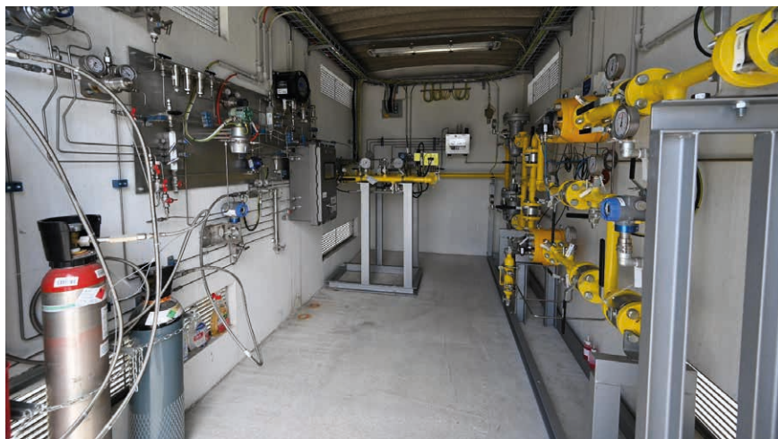
La cabina di analisi e misura, che verifica l'idoneità all'immissione in rete del biometano prodotto
