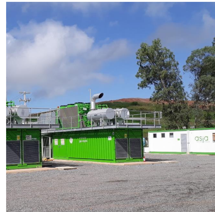
Landfill gas plant | João Pessoa (Paraíba - Brazil)
