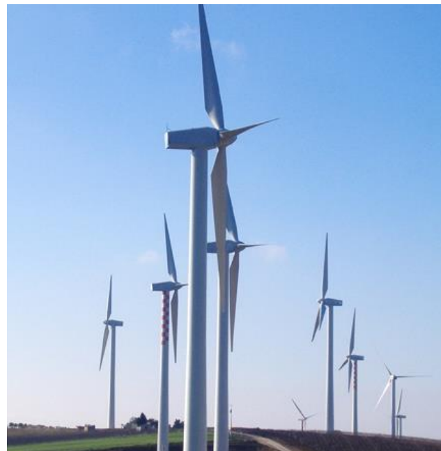
Parque Eólico | Fumosa (Tp, Italy)
