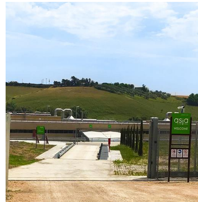
Usina de energia de FORSU Tuscania (Vt - Italia)
