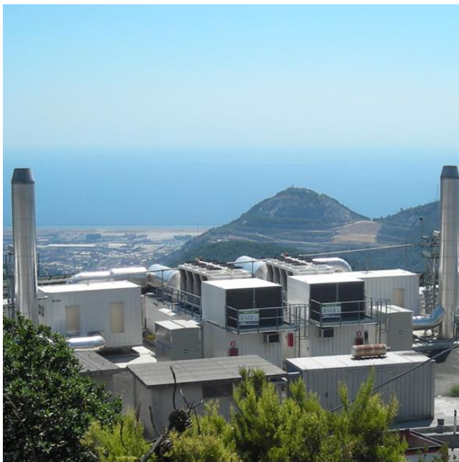
Planta de biogás de aterro sanitário Monte Scarpino (Ge - Itália)
