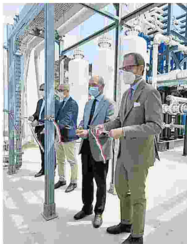
▲ Il taglio del nastro del nuovo impianto di Scarpino
